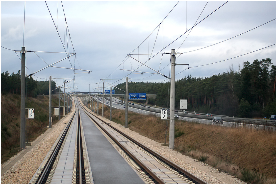
Abbildung 2: Enge Bündelung der Neubaustrecke Nürnberg–Ingolstadt mit der A9. Bildquelle Wikipedia.
